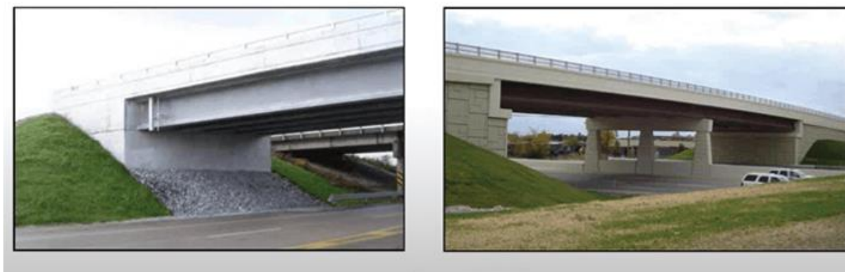
Рисунок 3. Интегральный мост Forder Valley Viaduct в Великобритании.
