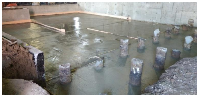
Рисунок 2. Фрагмент выпусков буринъекционных свай ЭРТ.
