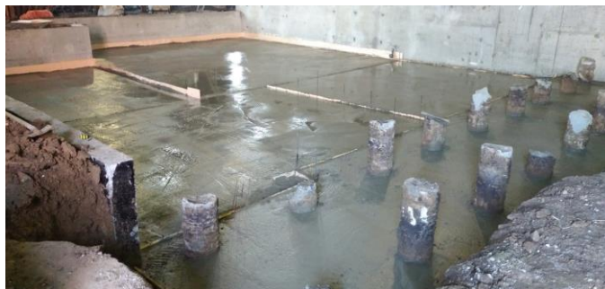
Рисунок 2. Фрагмент выпусков буроналивных свай ЭРТ.
