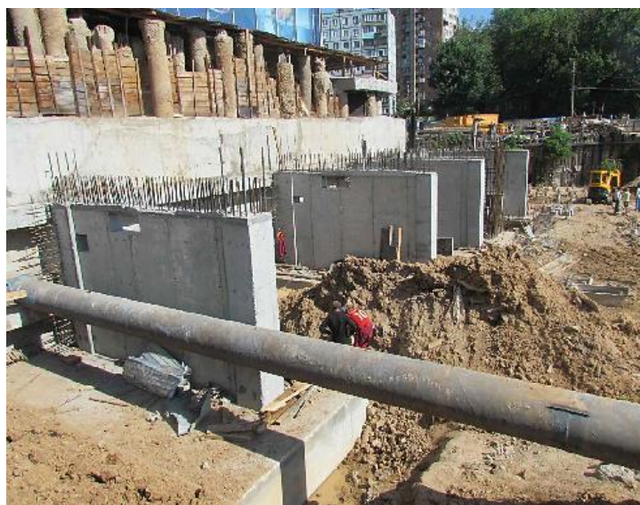
Рисунок 3. Фрагменты выполненных монолитных железобетонных контрфорсов: 1-существующие буронабивные сваи ограждения котлована; 2-ограждение котлована из монолитного железобетона; 3-монолитные железобетонные контрфорсы усиления существующей подпорной стены; 4-монолитный железобетонный ростверк; 5-существующая труба - расстрел усиления.
