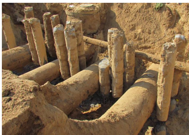
Рисунок 5. Фрагмент выпусков буронабъекционных свай ЭРТ устроенных в межтрубных пространствах магистральных напорных трубопроводов.
