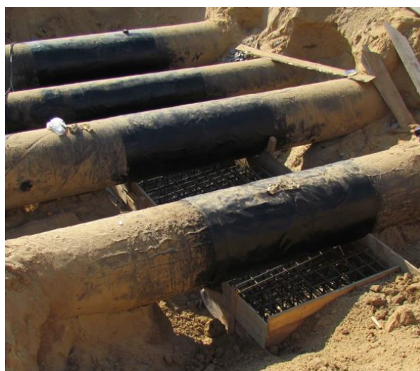
Рисунок 6. Фрагмент устройства монолитного железобетонного ростверка на стадии армирования.
