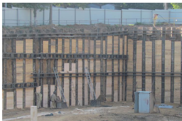
Рисунок 6. Ограждение котлована с использованием стальных труб и грунтовых анкеров ЭРТ в г. Чебоксары.
