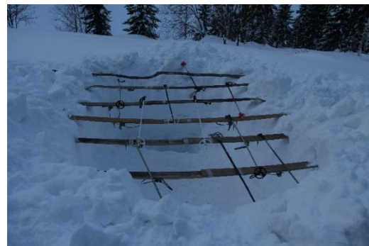
Рис. 2. Перекрытие снежной пещеры
