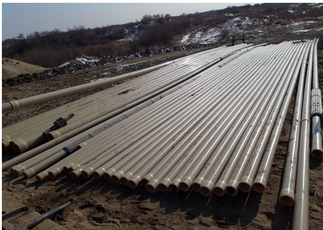
Рисунок 1. Откачные и закачные скважины, применяемые подземным способом выщелачивания.
