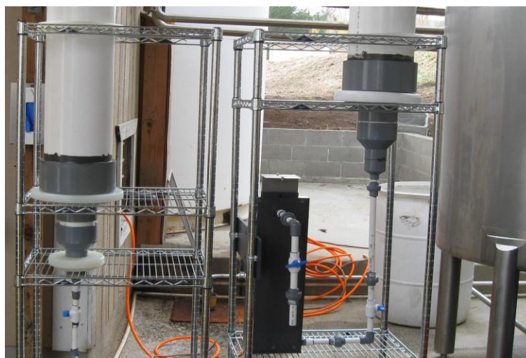
Рисунок 1, - на рисунке показан пример адаптации надсистемы электрохимического реактора в экосистеме реставрированного производственного помещения завода по производству молочных продуктов. Показанная надсистема выполнена с учётом всех требований экологических стандартов для полного соответствия которым создана конструкция электрохимического реактора в сочетании с вспомогательными элементами, управление и контроль которых осуществляется с применением элементов искусственного интеллекта и искусственных нейронных сетей.
