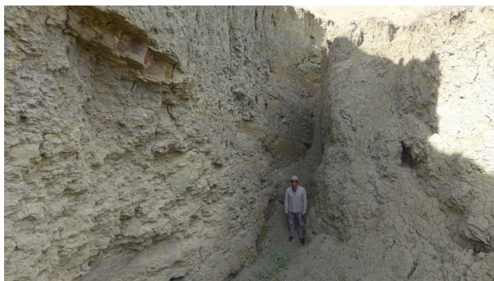
Рисунок 2. Блоковый техногенный оползень (линия обрушения), май 2020 г.
