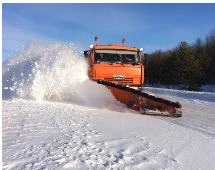
Рисунок 1. Зимнее содержание автомобильной дороги.
