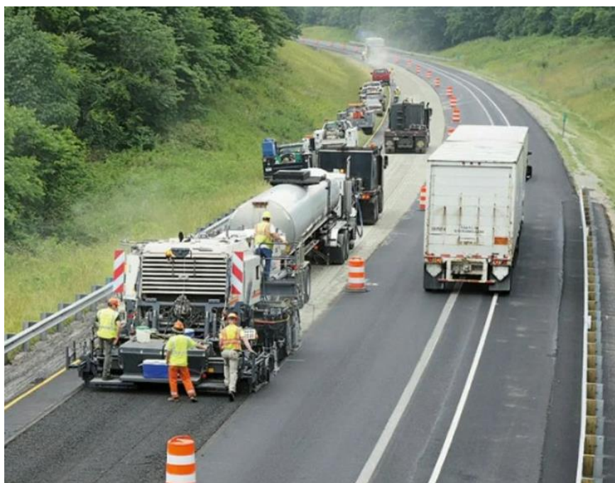
Рисунок 1. Устройство нижнего слоя покрытия методом холодной регенерации.
