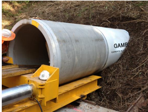
Рисунок 2. Линейный элемент для продавливания.
