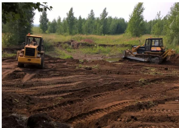
Рисунок 1. Снятие почвенно-плодородного слоя.
