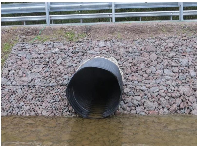
Рисунок 1. Водопропускная труба в теле насыпи.
