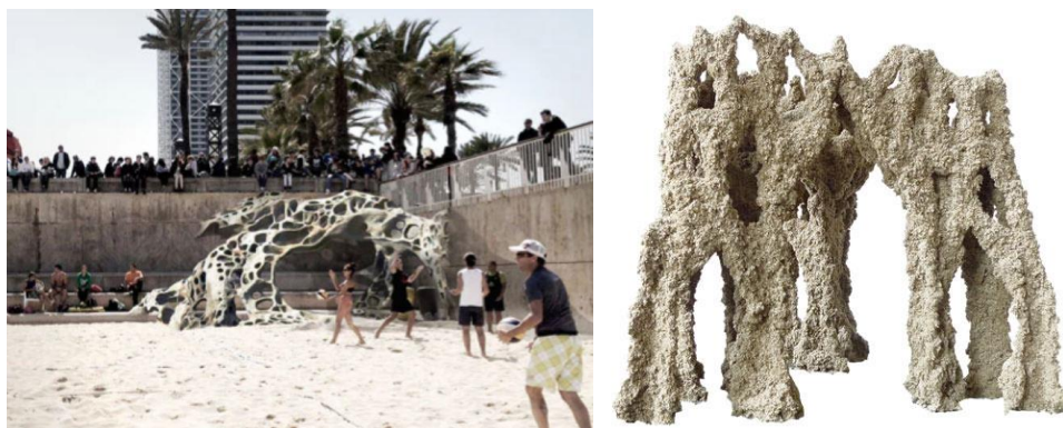
Рисунок 11. Архитектурное сооружение из песка и почвы, построенное 3D принтером.
