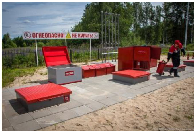
Рисунок 7. Первичные средства пожаротушения АЗС.
