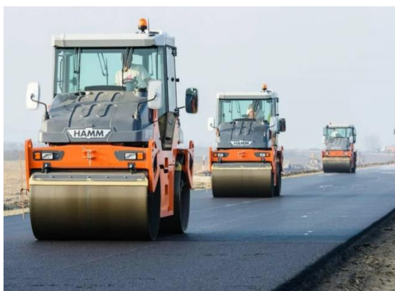
Рисунок 1. Укатка асфальтобетона на трассе М-7 «Волга».
