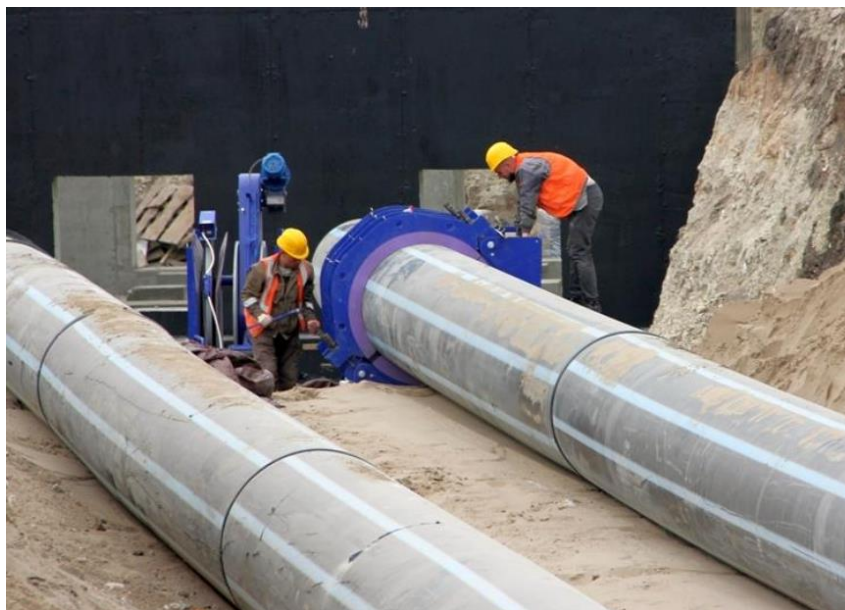
Рисунок 2. Монтаж новых сетей водоснабжения городского округа Самара.
