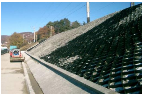
Рисунок 3. Укрепление откосов геосеткой из полимерных материалов.
