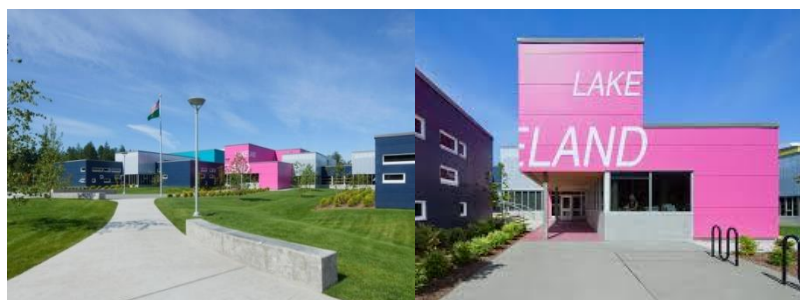
Рисунок 2. Архитектурное решение начальной школы Lakeland США.
