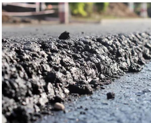
Рисунок 1. Кромка покрытия из щебеночно-мастичного асфальтобетона.
