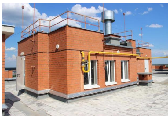
Рисунок 2. Встроенная (стационарная) котельная на крыше.
