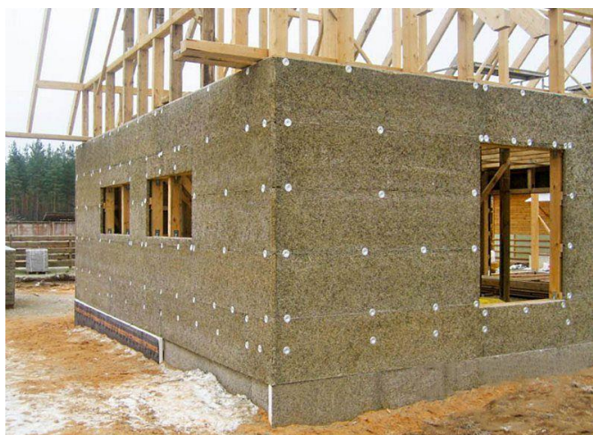
Рисунок 1. Использование блоков костробетона.
