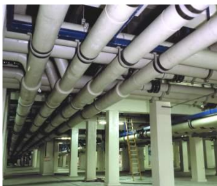
Рисунок 2. Трубы для транспортировки щелока.[6]
