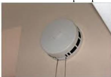
Рисунок 1. Приточный клапан КИВ - 125
