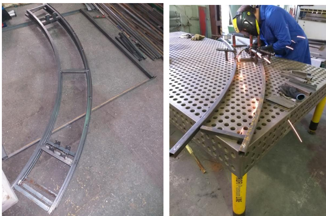
Рисунок 3. Сварочные работы при изготовлении каркаса скамеек
