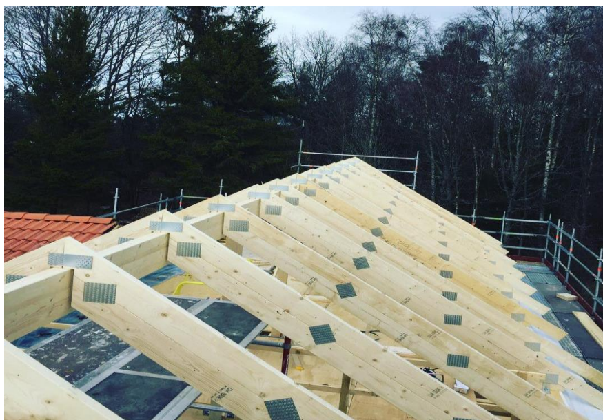
Рис. 3. Составные стропильные балки на МЗП
