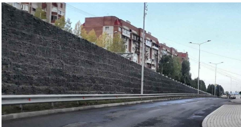
Рис. 4. Откос насыпи на подходе к путепроводу на ул. Ташкентская, укрепленный габионами
