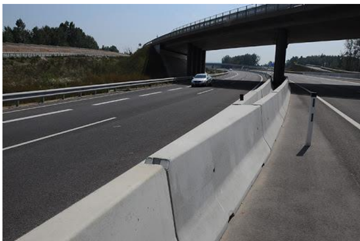
Дорожное ограждение «Нью-Джерси»
