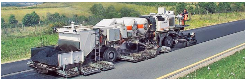
Рисунок 2 - Дорожное звено, выполняющее работы по ремонту автомобильной дороги методом холодной регенерации
