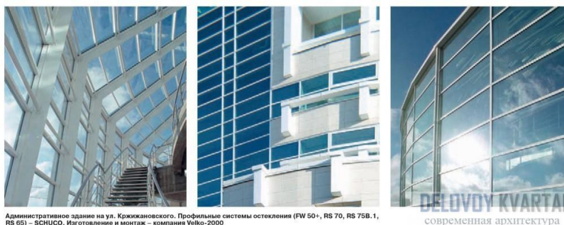
Административное здание на ул. Кржижановского. Профильные системы остекления (FW 50+, RS 70, RS 75B.1, RS 65) – SCHÜCO. Изготовление и монтаж – компания Уейко-2000
