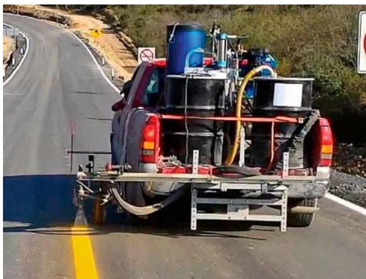
Рисунок 3 – Нанесение дорожной разметки с использованием холодного спрейпластика
