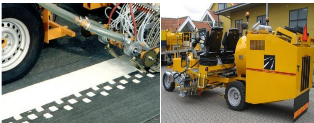
Рисунок 1 – Нанесение дорожной разметки термопластиком
