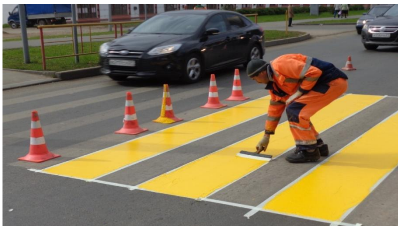
Рисунок 2 – Нанесение дорожной разметки холодным пластиком
