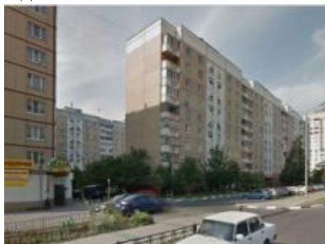
Рис.8. Многосекционный жилой дом по ул. Конева
