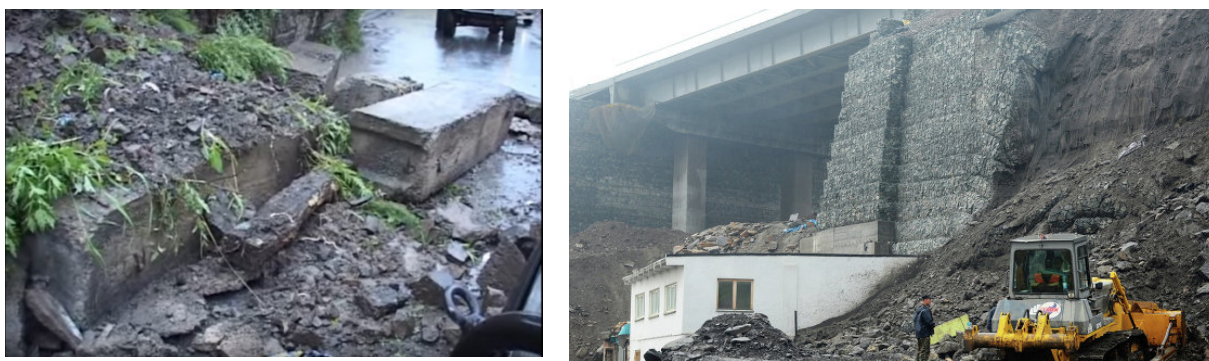
Рис. 3. Примеры обрушения подпорных стенок
