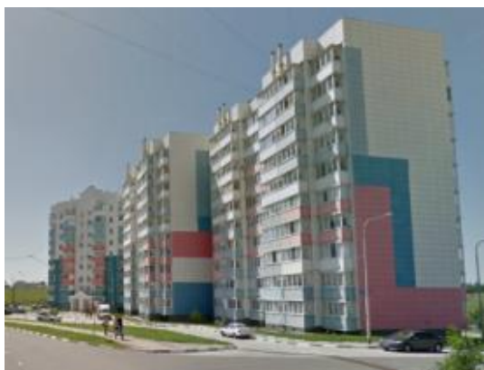
Рис. 12. Многосекционный жилой дом, 11-й Южный микрорайон.
