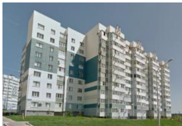
Рис. 13. Многосекционный жилой дом, 11-й Южный микрорайон.
