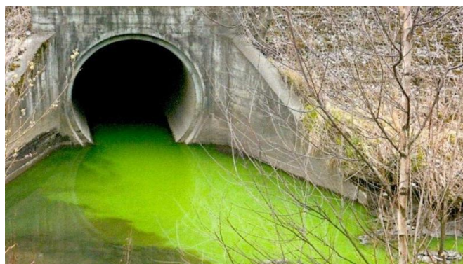
Рисунок 1. Эффект от применения метода цветовой визуализации сточных вод для выявления протечек и несанкционированных врезок в канализационные сети Санкт-Петербурга (Пресс-служба Северо-Западного межрегионального управления Росприроднадзора (20 апреля 2020 года) [5].
