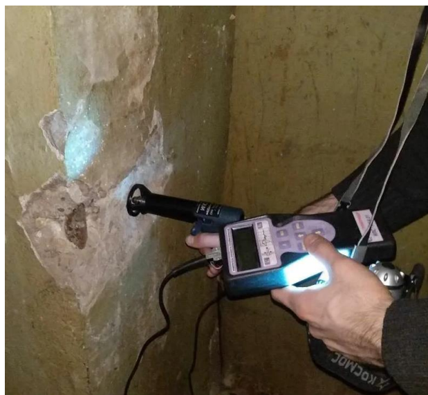
Рисунок 1. Оценка технического состояния. Установление прочности бетона методом ударного импульса.
