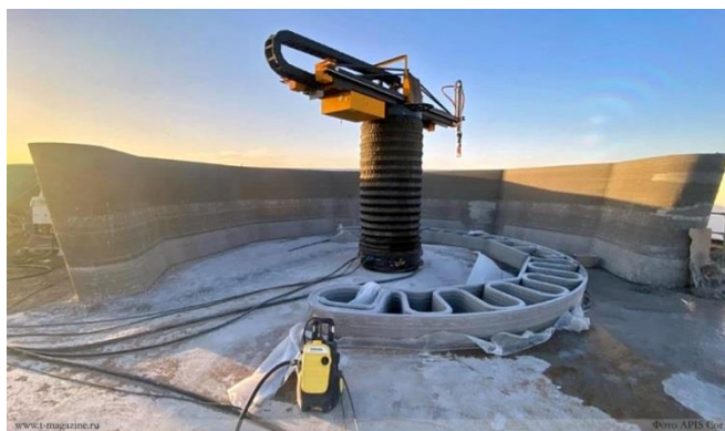
Рисунок 1. 3D-принтер. Печать домов из подвижных смесей.
