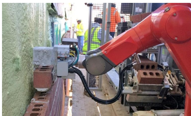
Рисунок 2. Применение робота. Робот выполняющий кирпичную кладку.
