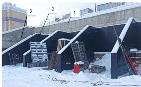
Рисунок 1. Монолитная железобетонная уголкообразная подпорная стена с контрфорсами как удерживающая заглубленная строительная конструкция деформированной подпорной стены: 1 – существующая монолитная железобетонная уголкообразная подпорная стена; 2 – монолитная железобетонная уголкообразная подпорная стена с контрфорсами 3.
