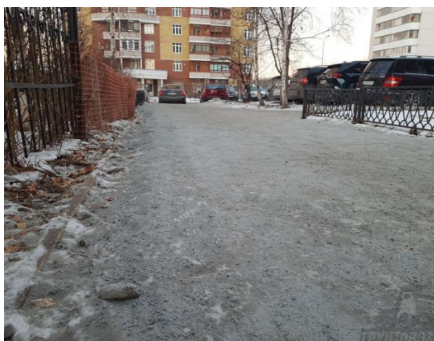
Рисунок 3. обработанный тротуар отсевом дробления щебня.
