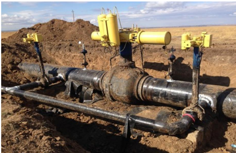
Рисунок 1. Отклонение положения кранового узла от проектного положения.
