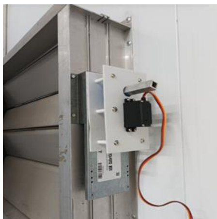
Рисунок 5. Металлические жалюзи в помещении после автоматизации.
