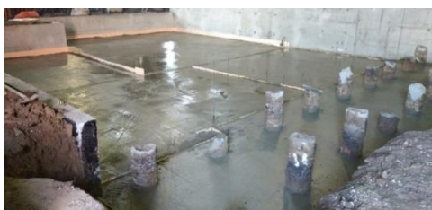
Рисунок 2. Фрагмент выпусков буринъекционных свай ЭРТ.
