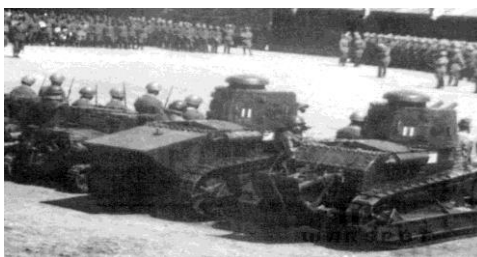
Рисунок 5. Пушечный FIAT 3000A (справа) и огнеметный FIAT 3000A (слева) [10].
