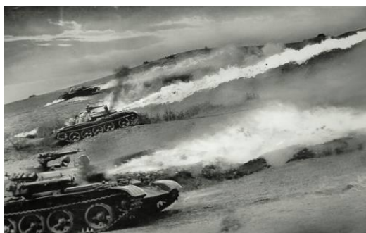
Рисунок 6. Танки с автоматическим пороховым огнеметом [19].
