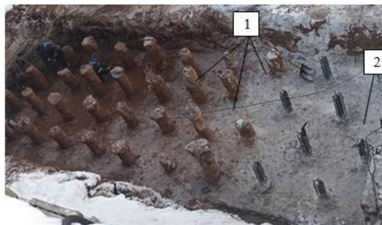
Рисунок 2. Свайное поле под монолитный железобетонный контрфорс: 1 – оголовки буронабивных свай ЭРТ; 2 – бетонная подготовка под ростверк.
