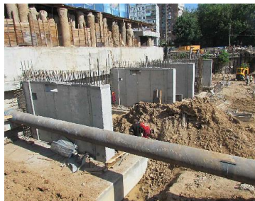
Рисунок 2. Фрагменты выполненных контрфорсов.
