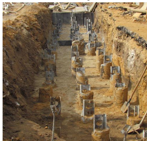
Ленточное свайное поле из буронабивных свай ЭРТ (РИТ, ФОРСТ, ЭРСТ) вдоль улицы Пожарской в г. Нижний Новгород
