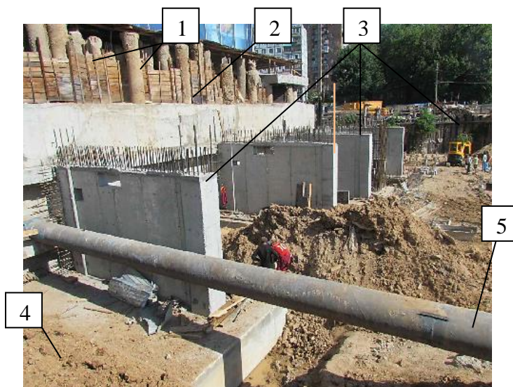
Рисунок 3. Фрагменты выполненных монолитных железобетонных контрфорсов: 1 – существующие буронабивные сваи ограждения котлована; 2 – ограждение котлована из монолитного железобетона; 3 – монолитные железобетонные контрфорсы усиления существующей подпорной стены; 4 – монолитный железобетонный ростверк; 5 – существующая труба – расстрел усиления.
