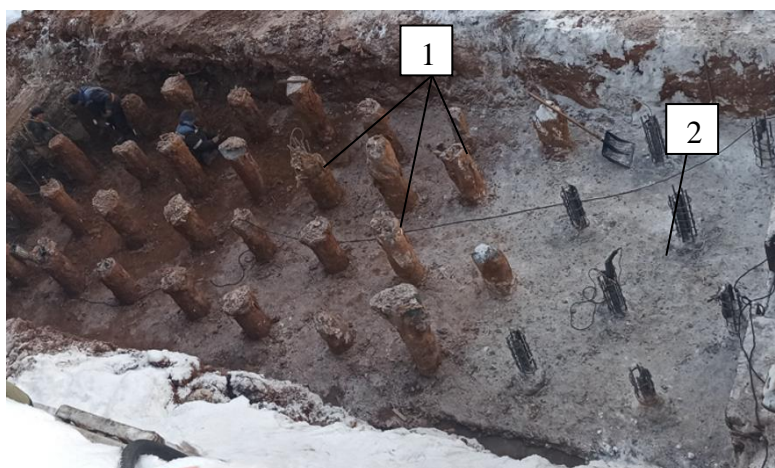
Рисунок 2. Свайное поле под монолитный железобетонный контрфорс 1 – оголовки буронабъекционных свай ЭРТ; 2 – бетонная подготовка под ростверк.
