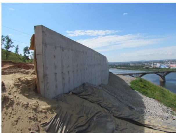
Монолитная железобетонная уголкового подпорная стена как заглубленная удерживающая конструкция на сваях ЭРТ (РИТ, ФОРСТ, ЭРСТ) на Окском съезде в г. Н. Новгород
