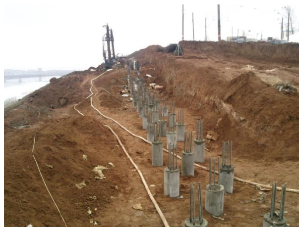
Ленточное свайное поле из буроинъекционных свай ЭРТ (РИТ, ФОРСТ, ЭРСТ) под монолитную уголкового подпорную стену на Окском съезде в г. Н. Новгород
