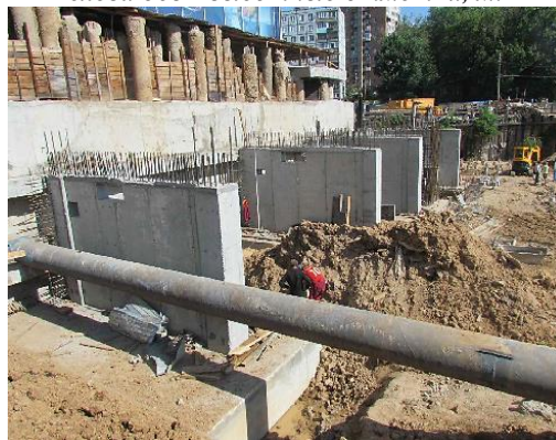
Рисунок 2. Фрагменты выполненных контрфорсов.
