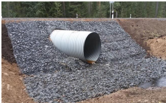
Рисунок 4. Пример металлической гофрированной водопропускной трубы.
