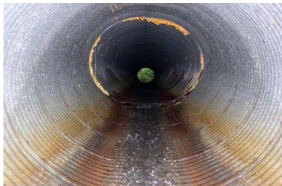
Рисунок 4. Коррозионные повреждения
