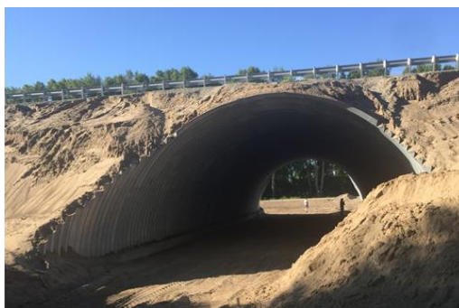
Рисунок 1. Общий вид пропускного сооружения.
