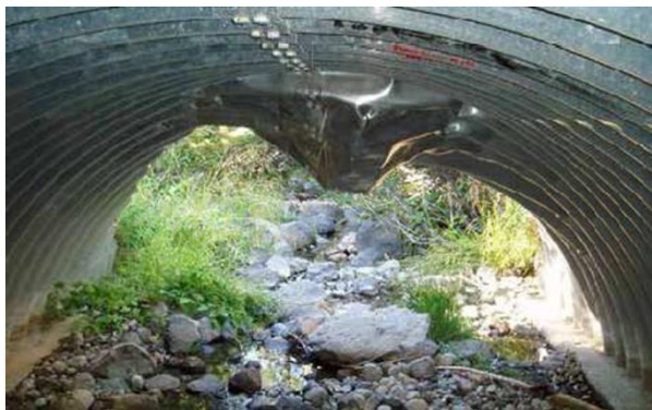
Рисунок 3. Деформации гофрированных листов
