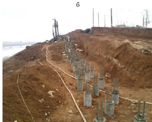
Ленточное свайное поле из буроинъекционных свай ЭРТ (РИТ, ФОРСТ, ЭРСТ) под монолитную уголковую подпорную стену на Окском съезде в г. Н. Новгород
