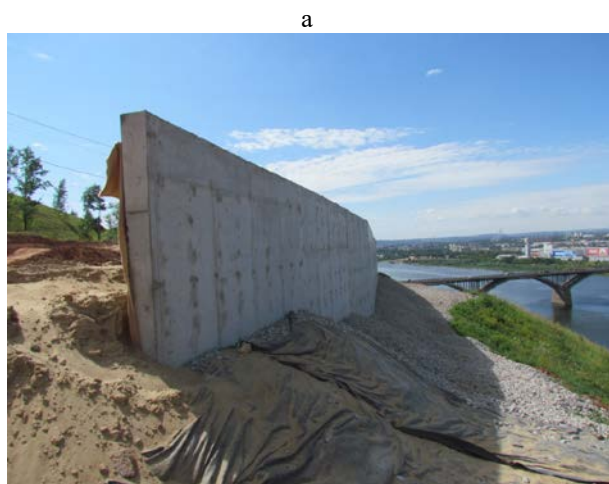
Монолитная железобетонная уголковая подпорная стена как заглубленная удерживающая конструкция на сваях ЭРТ (РИТ, ФОРСТ, ЭРСТ) на Окском съезде в г. Н. Новгород
