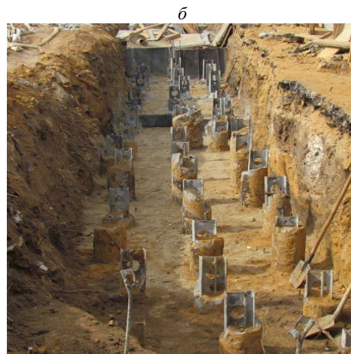
Ленточное свайное поле из буроинъекционных свай ЭРТ (РИТ, ФОРСТ, ЭРСТ) вдоль улицы Пожарской в г. Нижний Новгород
