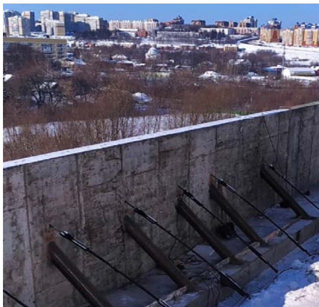
Рисунок 3. Заглубленные удерживающие железобетонные конструкции с использованием буринъекционных свай ЭРТ (РИТ, ФОРСТ, ЭРСТ), грунтовых анкеров ЭРТ и монолитных железобетонных угловых подпорных стен в г. Чебоксары.
