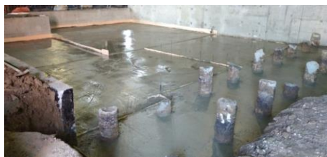
Рисунок 2. Фрагмент выпусков буроналивных свай ЭРТ.
