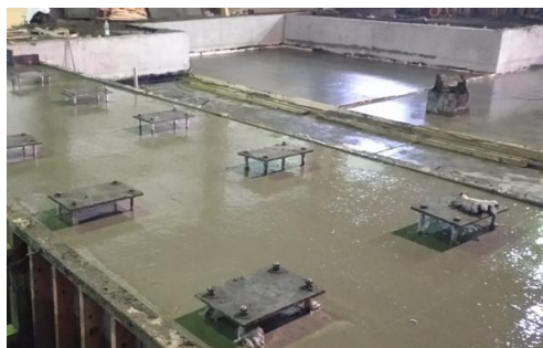
Рисунок 3. Фрагмент готовой монолитной железобетонной конструкции под монтаж надфундаментных конструкций и оборудования.
