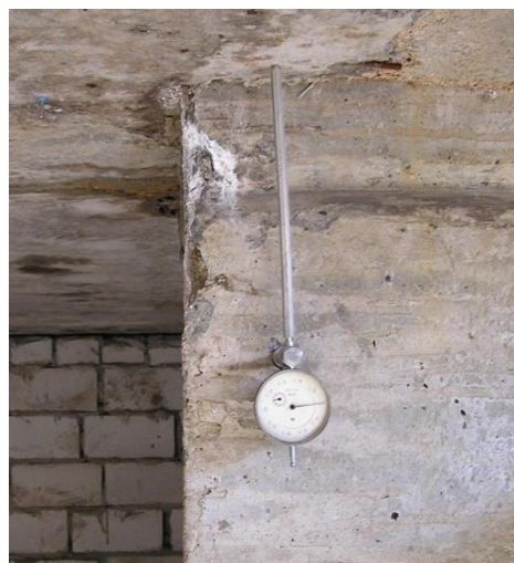
Рисунок 3. Индикатор часового типа, измеряющий деформации узла сопряжения «ригеля» и колонны.
