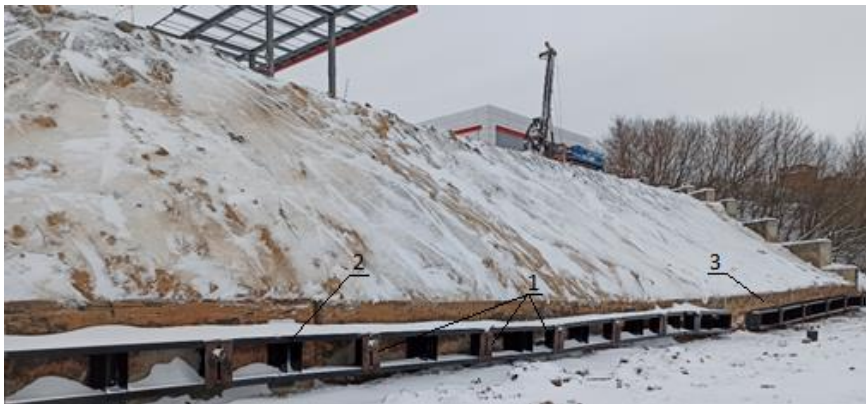
Рисунок 3. Фотография анкерного крепления деформированного откоса на оползневом склоне на абсолютной отм. 94.60: 1 – грунтовый анкер; 2 – анкерный обвязочный пояс; 3 – уголкового монолитные железобетонные подпорные стены.
