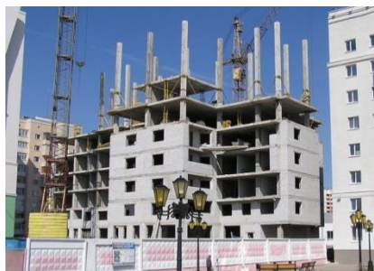
Рисунок 1. Общий вид строящегося в г. Белгород здания со сборно-монолитным «безригельным» каркасом.
