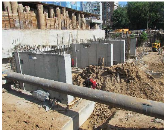
Рисунок 2. Фрагменты выполненных контрфорсов.
