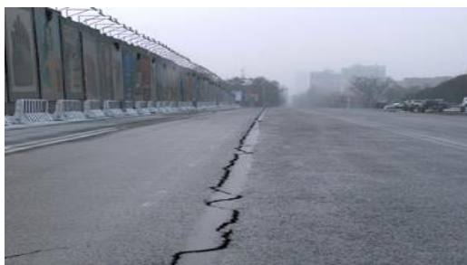
Рисунок 1. Одиночная трещина.
