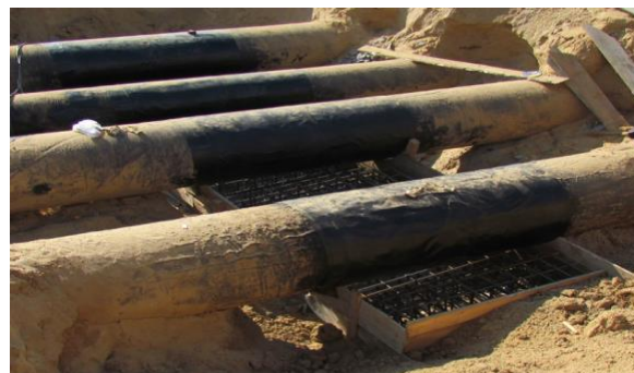
Рисунок 6. Фрагмент устройства монолитного железобетонного раствержка на стадии армирования.
