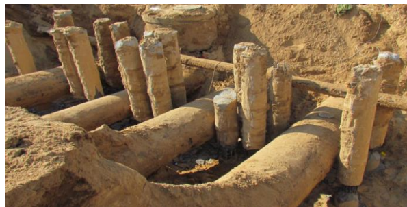
Рисунок 5. Фрагмент выпусков буринъекционных свай ЭРТ устроенных в межтрубных пространствах магистральных напорных трубопроводов.
