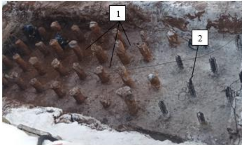
Рисунок 2. Свайное поле под монолитный железобетонный контрфорс: 1 - оголовки буронабвекционных свай ЭРТ; 2 - бетонная подготовка под ростверк.
