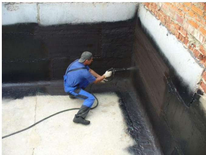
Рисунок 2. Установка гидроизоляционного барьера при понижении пола подвала.
