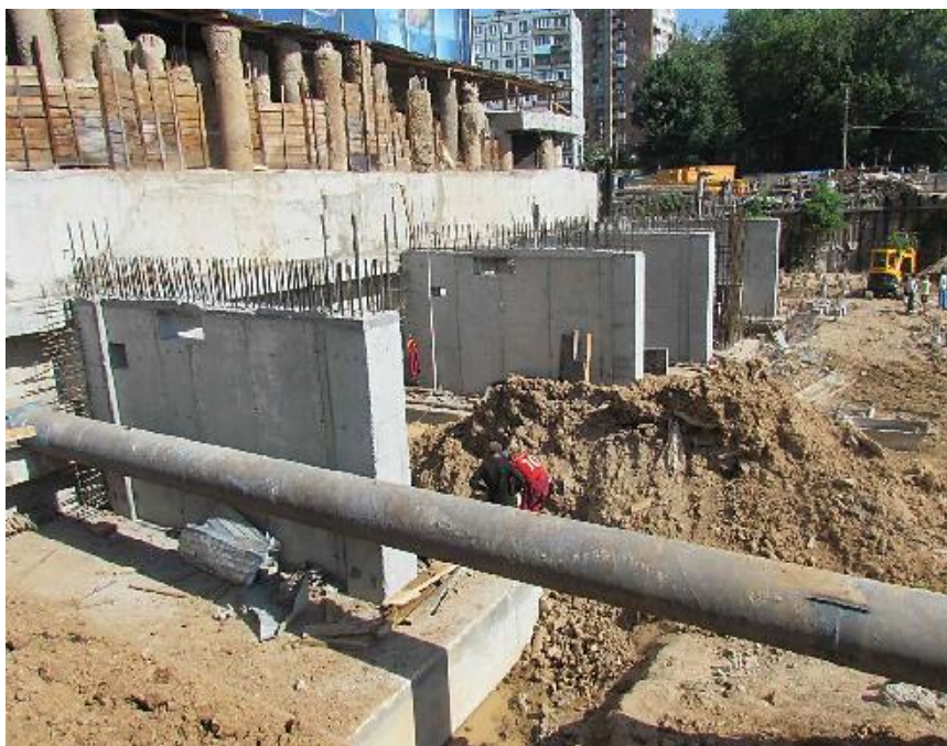
Рисунок 2. Фрагменты выполненных контрфорсов.
